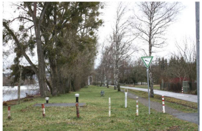
Reichlich eng für einen Spielplatz mit diversen Hindernissen: Entlüftungspoller der Fernwasserversorgung, Zufahrtsweg für das Spülfahrzeug des Hauptkanals ...
