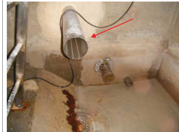
Abbildung 19 - Rohrinstallation in einer Wasserkammer
