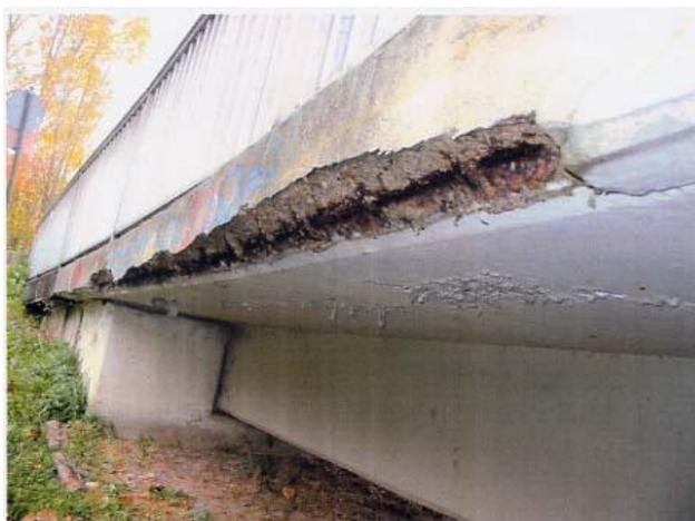
Betonschädigungen am Steg – Korrosion der Armierung sprengt den Beton ab
