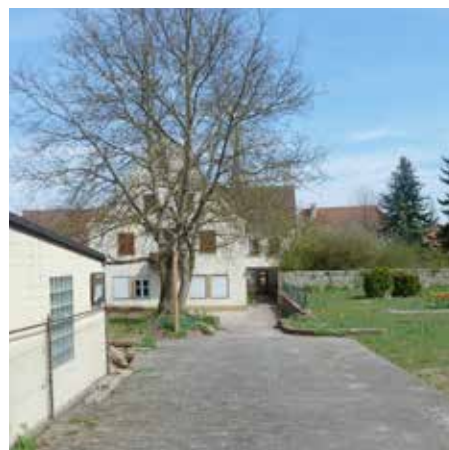
Gebäudeleerstand alter Kindergarten
