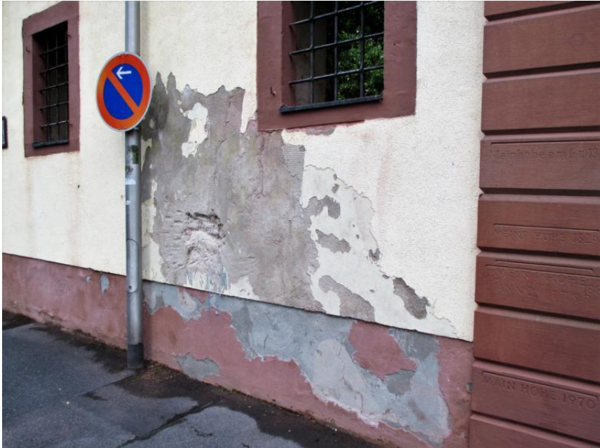
Fassade vor Sanierung
