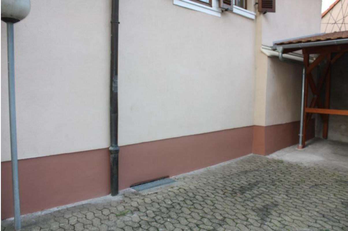
Fassade nach Sanierung
