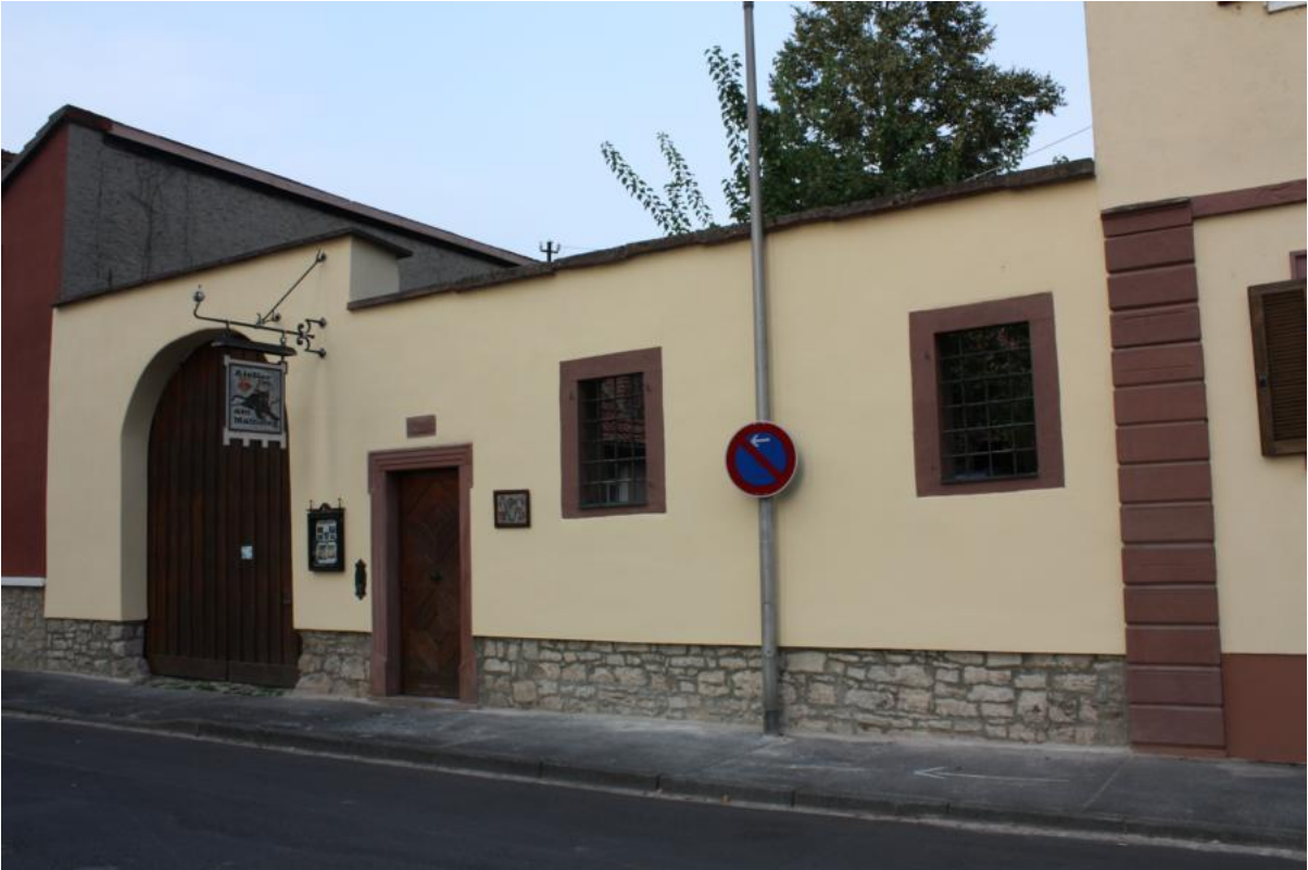
Fassade nach Sanierung
