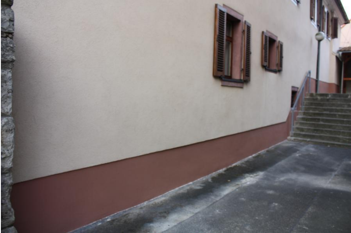
Fassade nach Sanierung
