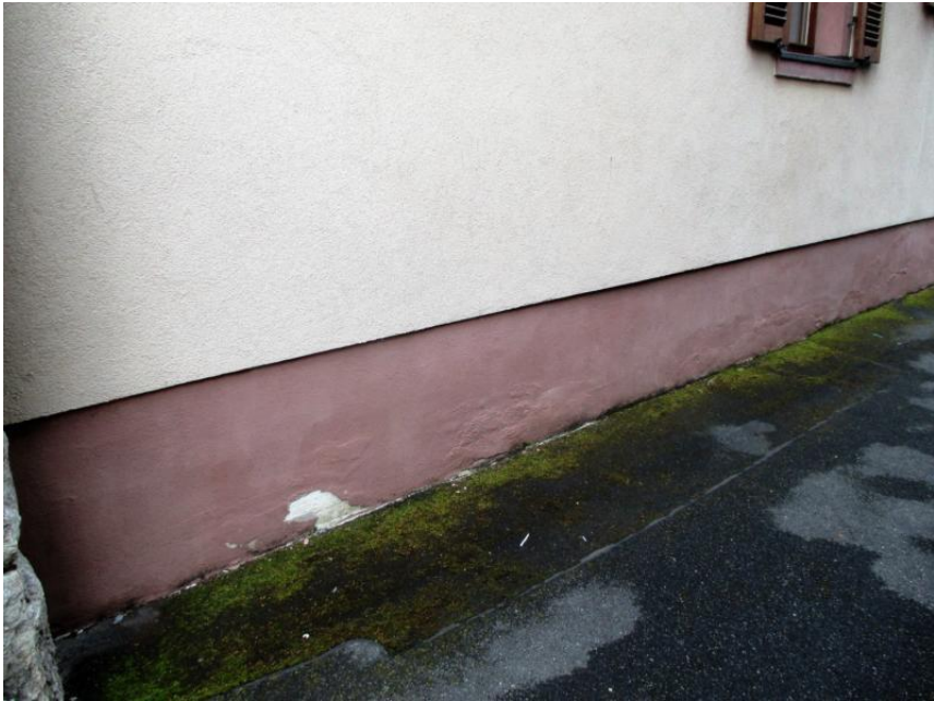
Fassade vor Sanierung
