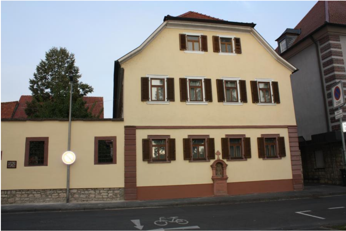
Fassade nach Sanierung
