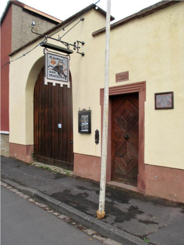
Fassade vor Sanierung
