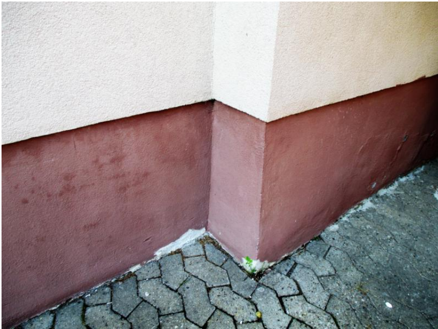
Fassade vor Sanierung
