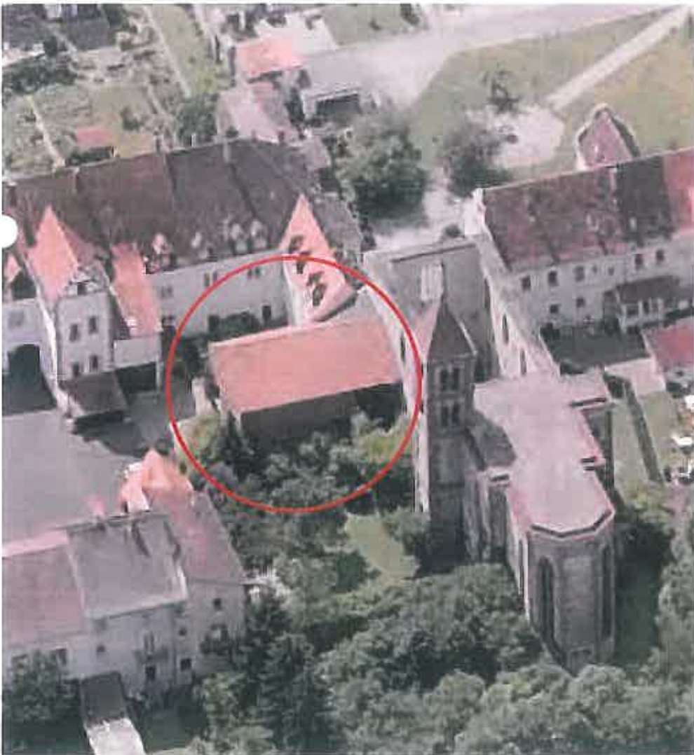
ABBRUCH SCHEUNE LUFTBILDER
